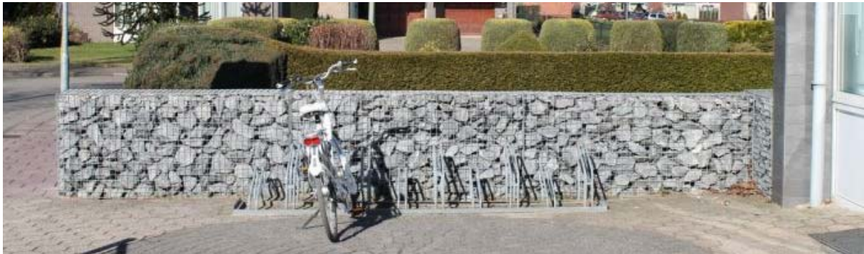
Abb. 23: Drahtschotterkörbe mit Sitzfläche aus recyceltem Kunststoff; mit Füllmaterial von 20-35cm grossen Steinen für ausreichend Hohlraumsysteme der Eidechsen und Blindschleichen, Beispielbilder der Fa. Gabinova
