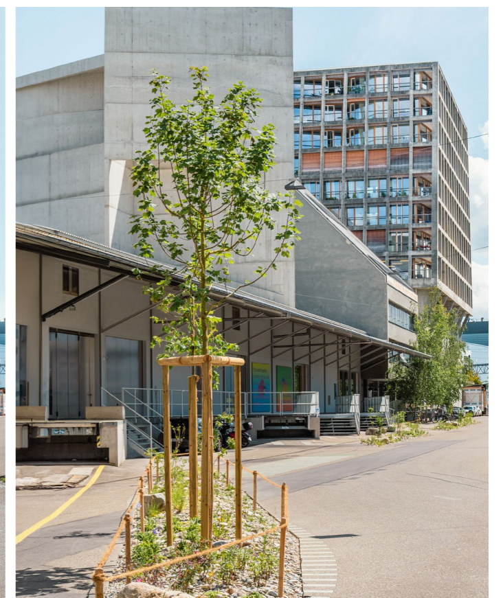
Nachher: Anlieferung Kreuzung Florenz-Strasse / Helsinki-Strasse
