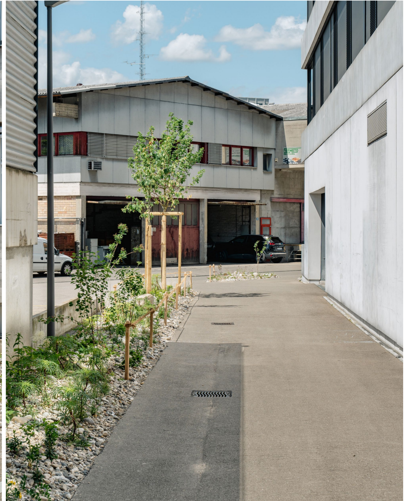
Entlastung der Kanalisation durch Entsiegelung
