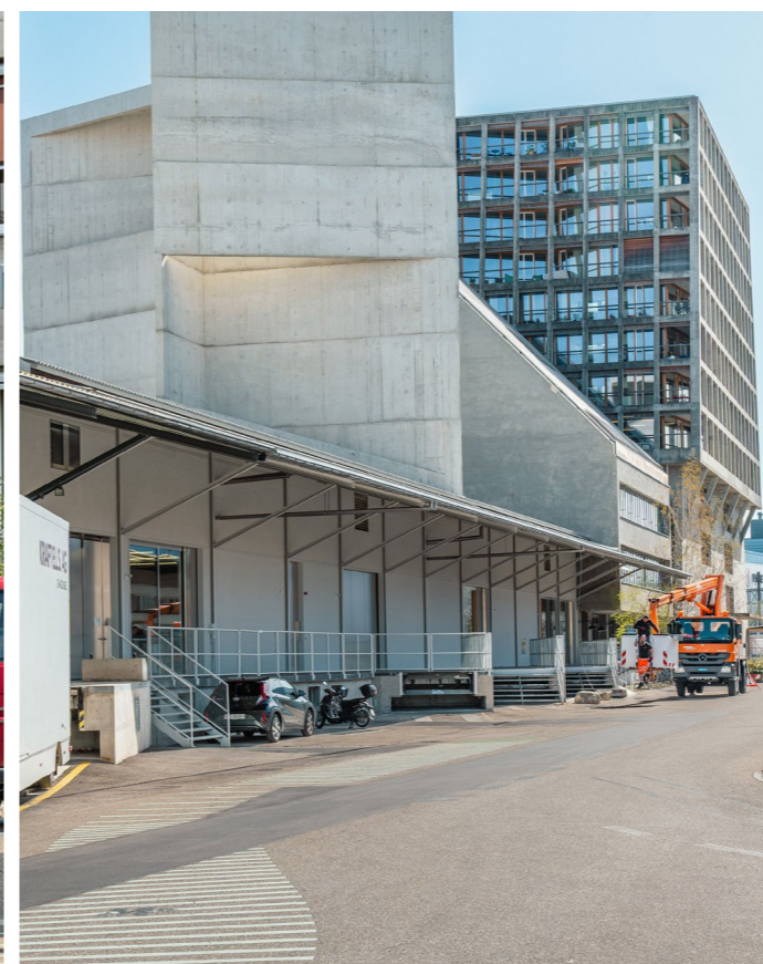
Vorher: Anlieferung Kreuzung Florenz-Strasse / Helsinki-Strasse
