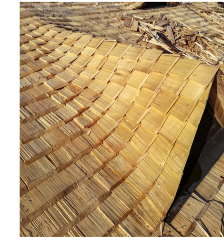
Referenzbild Materialisierung Dächer: Holzschindel auf Stahlstruktur, definitive Farbe noch zu bestimmen
