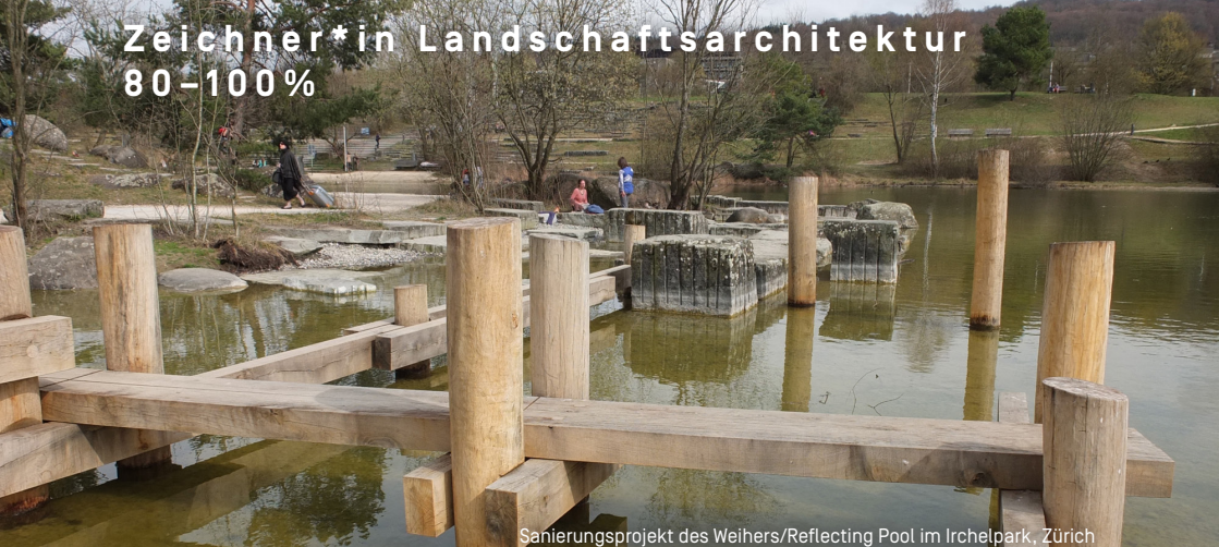
Sanierungsprojekt des Weihers/Reflecting Pool im Irchelpark, Zürich
