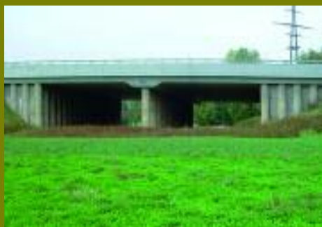
Wildtierkorridor Grosszelg, Birmenstorf AG
